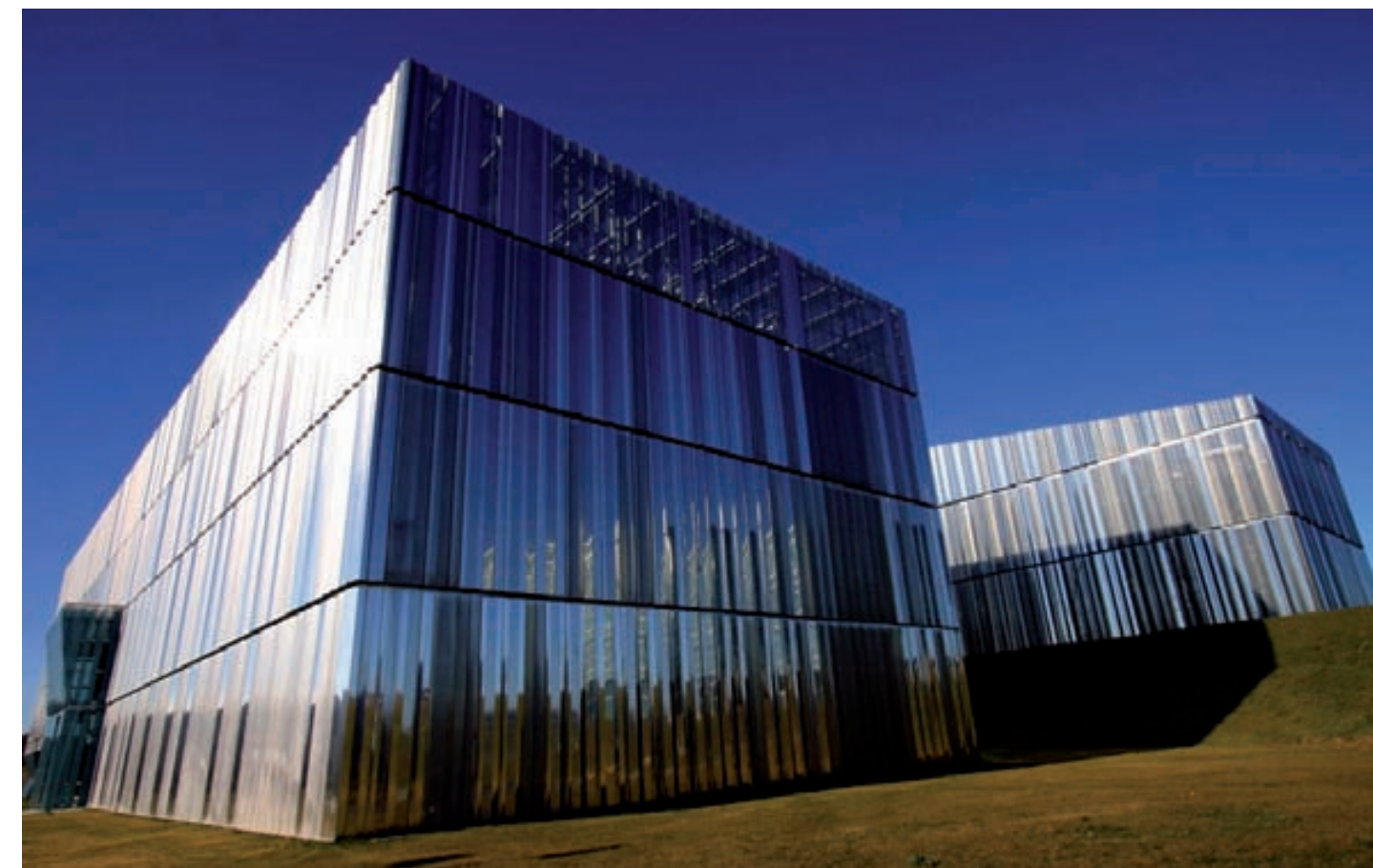
■ Centro de Investigación "Energigune" no Parque Tecnológico de Miñano, Álava Área construída. 5.847m 2 Classificação energética A. Uso de sistemas alternativos de aquecimento, como biomassa, geotermia, assim como placas solares e fotovoltaicas Edifício caracterizado pela utilização de placas de aço inox dobrado que reflectem a envolvente Arquitecto. Javier Aja Cantalejo - ACXT (Idom)
