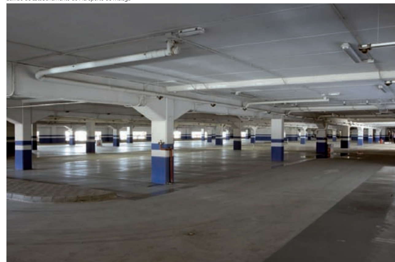
Edifício de Estacionamento do Aeroporto de Málaga
