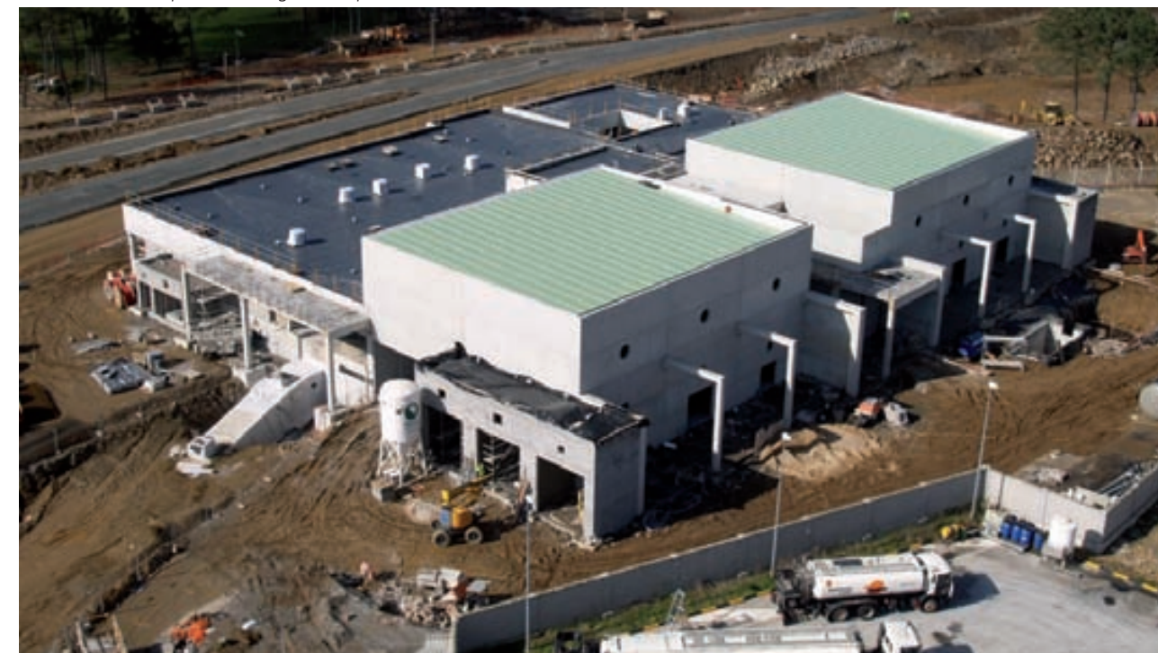
Central Eléctrica, Aeroporto de Santiago de Compostela
