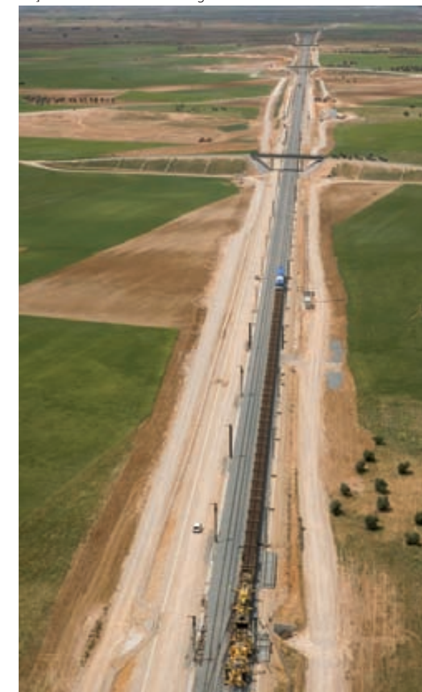
Troço Ocaña - Villarubia de Santiago. AVE Madrid - Valência
