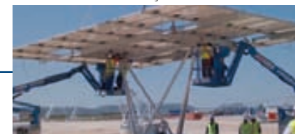
Manutenção de Centrais Fotovoltaicas
