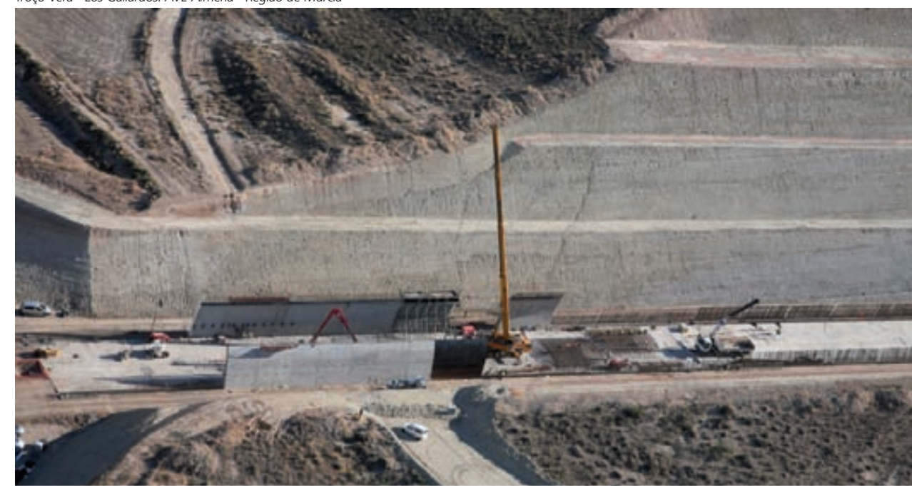
Troço Vera - Los Gallardos. AVE Almería - Região de Murcia
