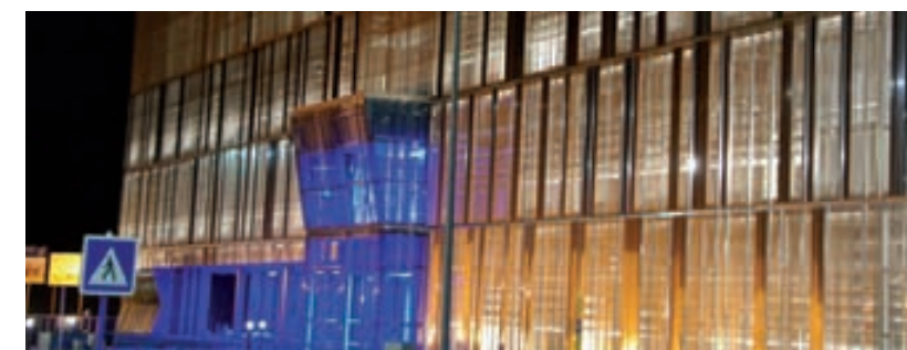
■ Centro de Investigación "Energigune" no Parque Tecnológico de Miñano, Álava Área construída. 5.847m 2 Classificação energética A. Uso de sistemas alternativos de aquecimento, como biomassa, geotermia, assim como placas solares e fotovoltaicas Edifício caracterizado pela utilização de placas de aço inox dobrado que reflectem a envolvente Arquitecto. Javier Aja Cantalejo - ACXT (Idom)
