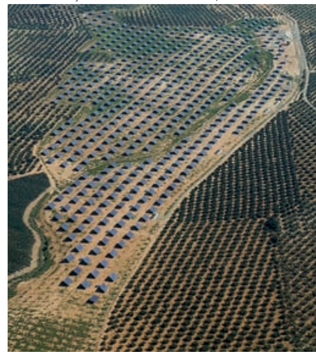
Central de Produção Eléctrica Fotovoltaica de El Gallo, Jaén
