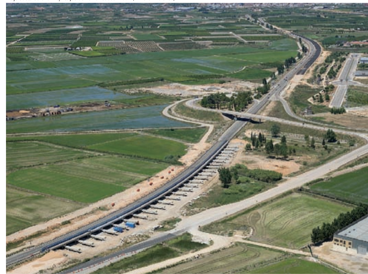
Troço Sueca-Sollana. Duplicação de via na Estrada N-332 (Almería - Valência)
