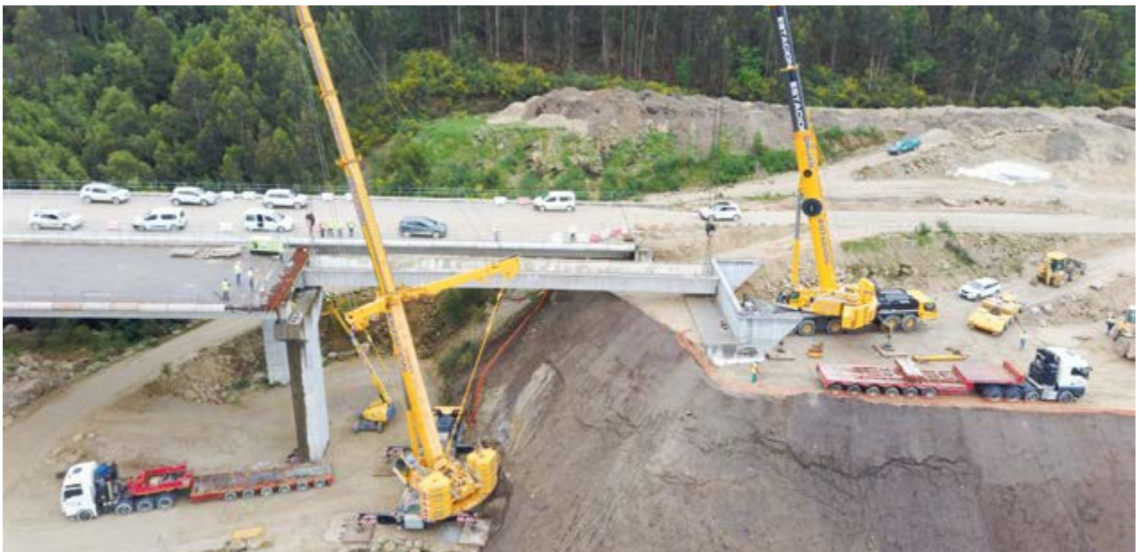
Tramo Vilaboa – A Ermida de la futura Autovía A-57, Pontevedra (España)
