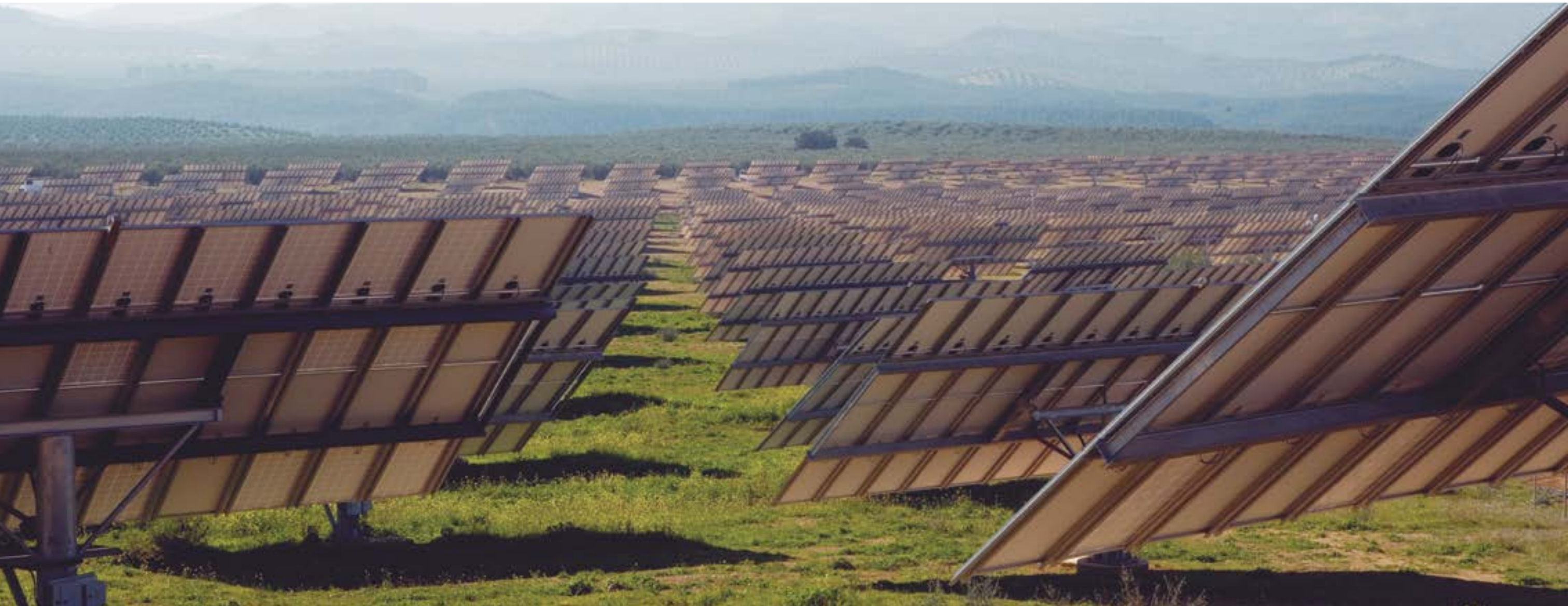
Centrale photovoltaïque à Alcaudete, Jaén / 5,4 MW
