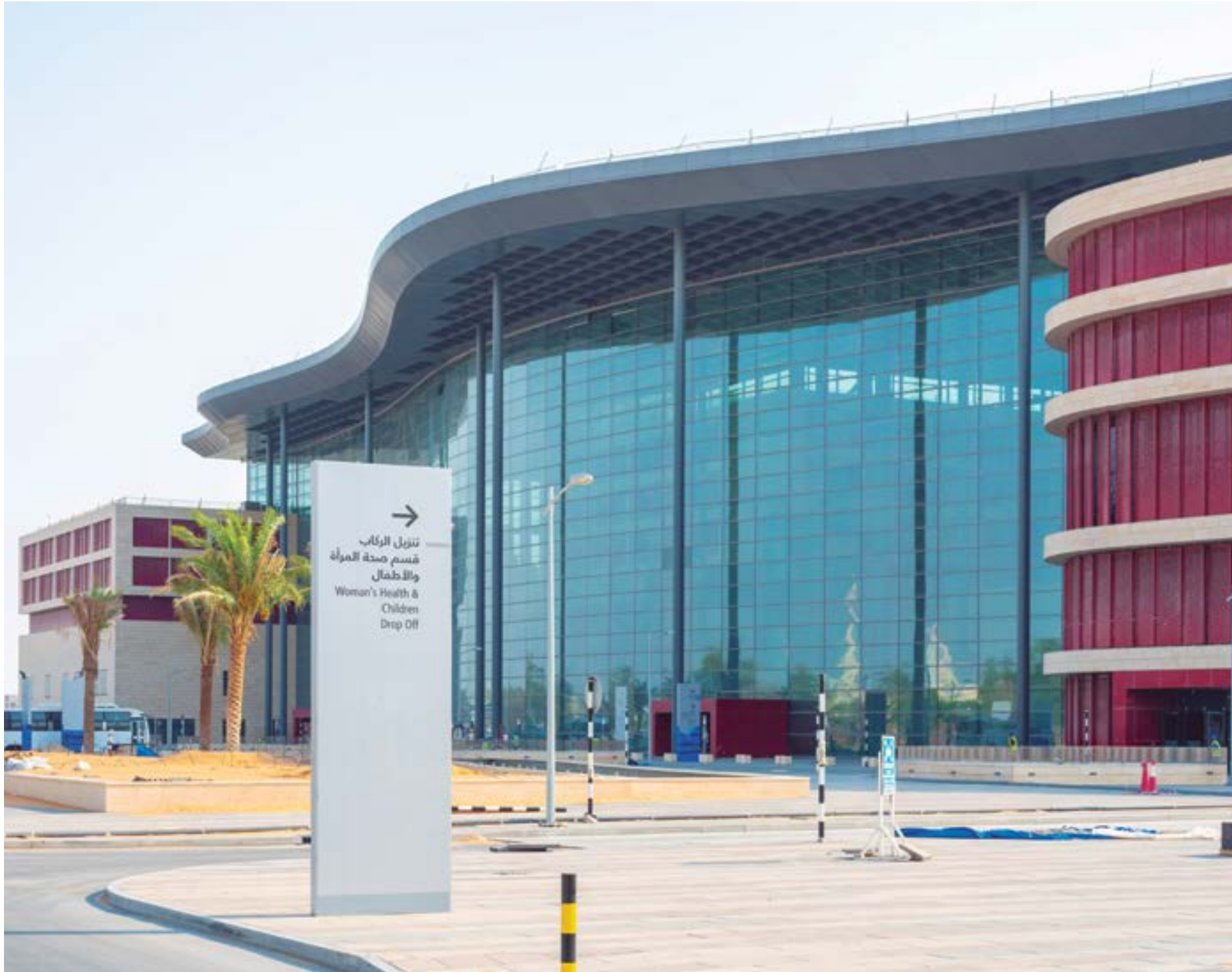
Hôpital Al Ain, Abu Dhabi (Émirats Arabes Unis)
