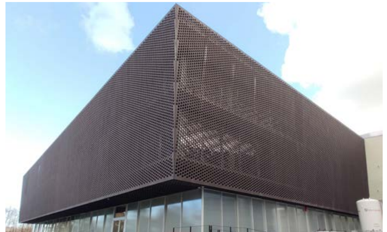
Construction et urbanisation dans le parc technologique de Miramón, San Sebastián
