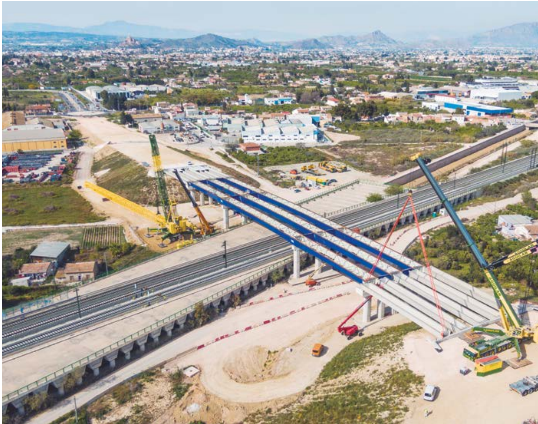
Tronçon Autoroute du Reguerón du périphérique MU-30 de Murcie (Espagne)
