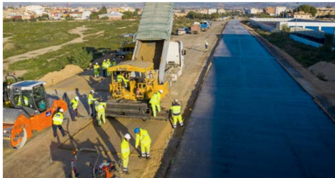
Équipe humaine dans la construction du tronçon autoroutier Reguerón de la Circunvalación MU-30 de Murcie (Espagne)
