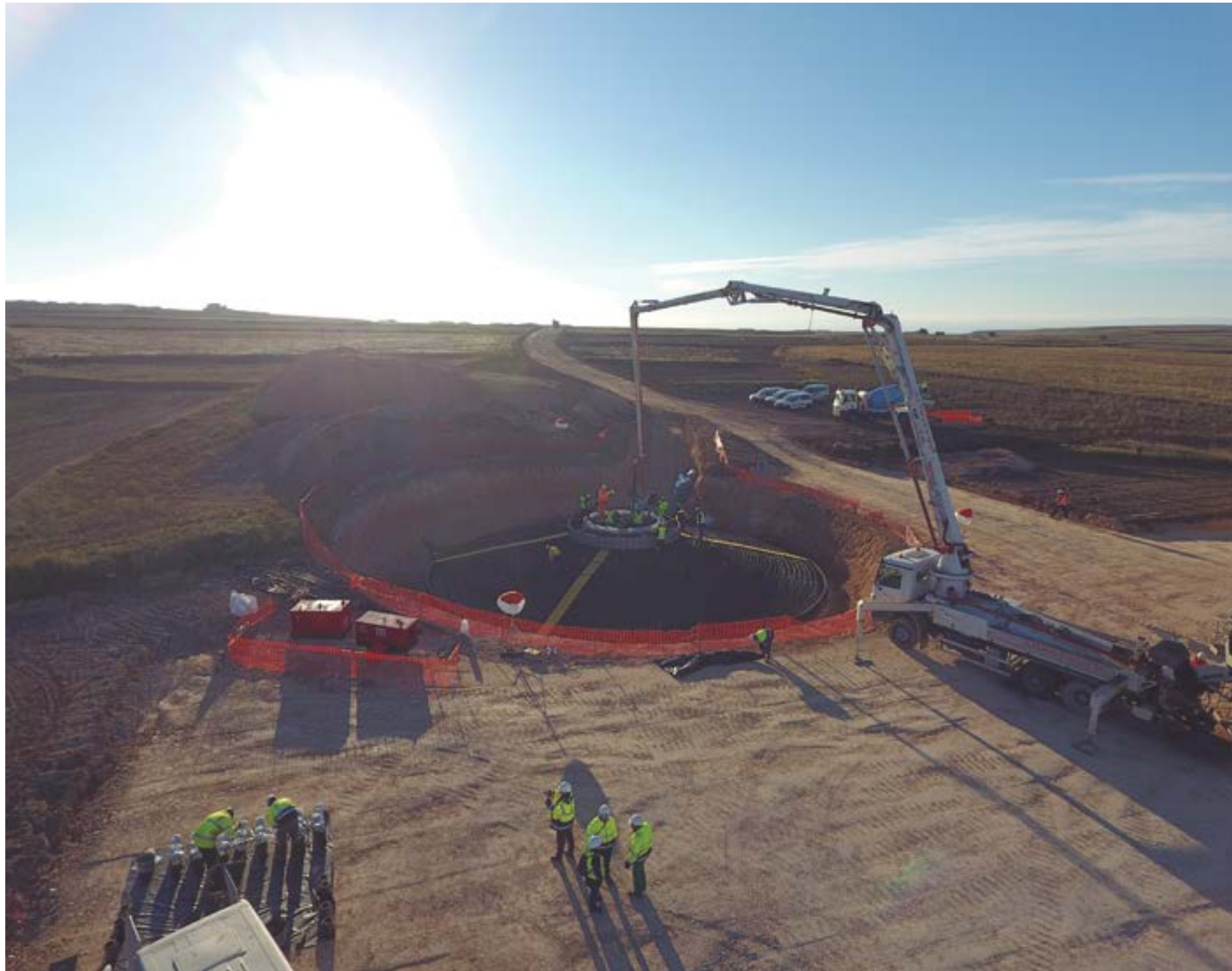
Parc éolien de 50,4 MW à Muniesa, Teruel (Espagne)
