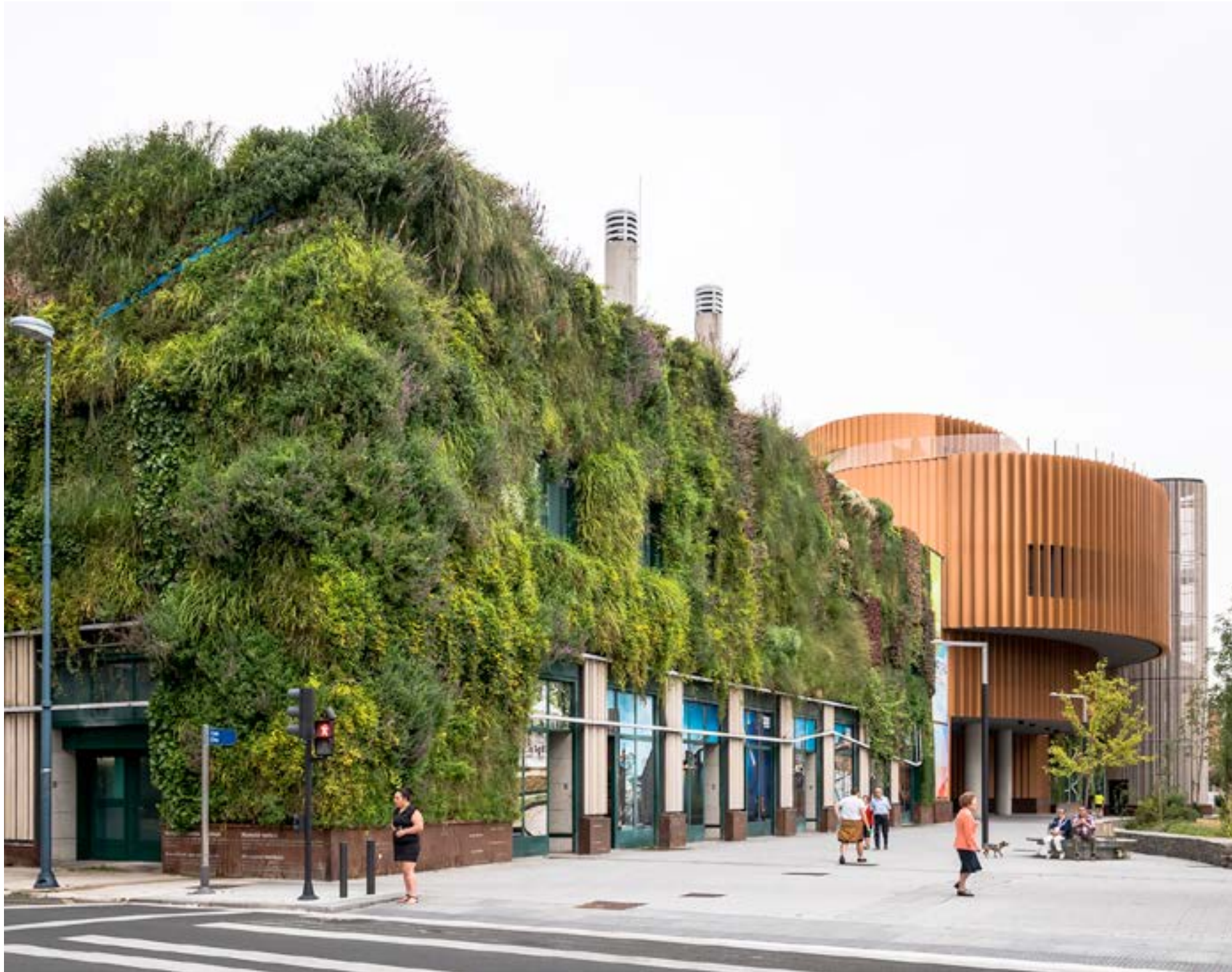
Gestion de l'approvisionnement en énergie électrique, optimisation et maintenance avec garantie totale des bâtiments de la Mairie de Vitoria. Palais des Congrès Europa, Vitoria-Gasteiz, Álava
