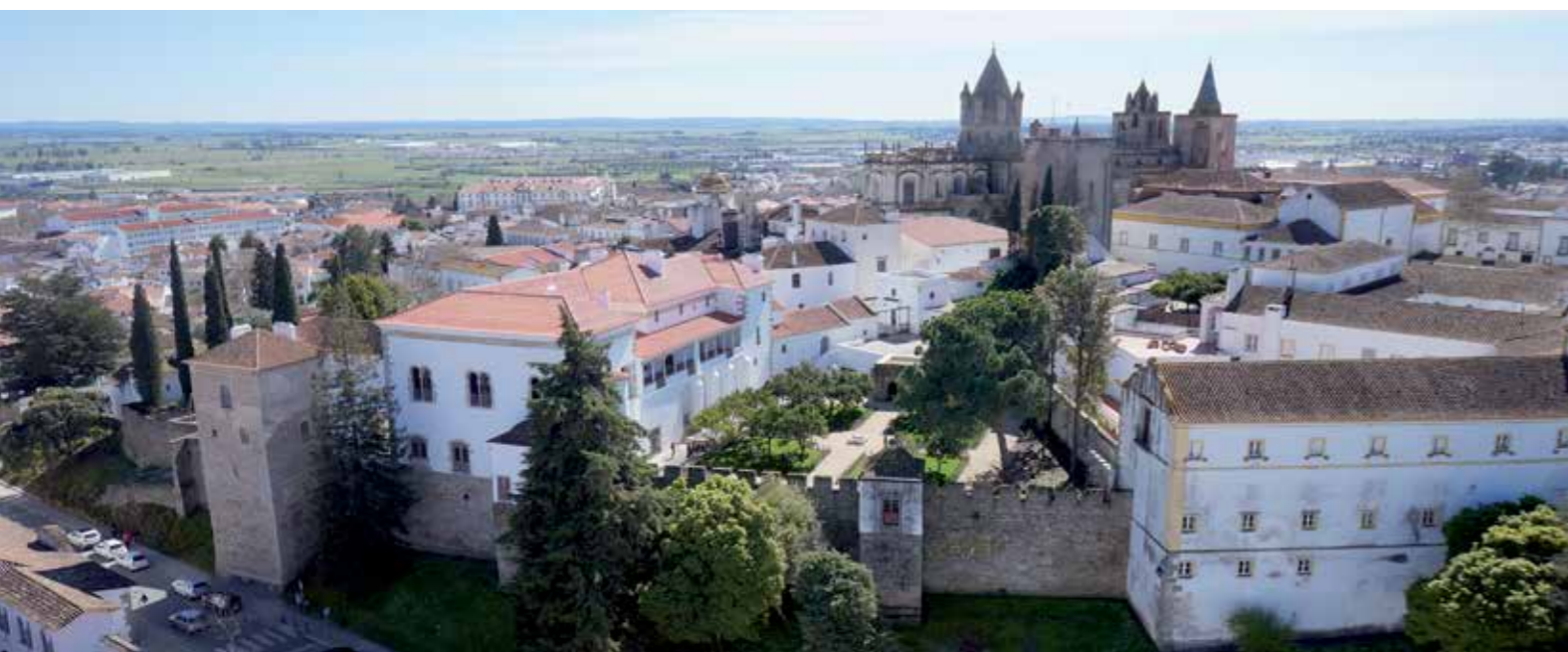
Restoration of the Palacio de la Inquisición, Casas Pintadas y Patio de San Miguel de Évora (Portugal)
