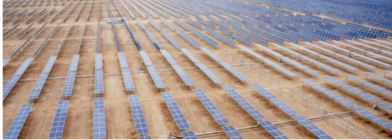
20 MW PV solar plant in Alto de la Alianza, Tacna (Peru)
