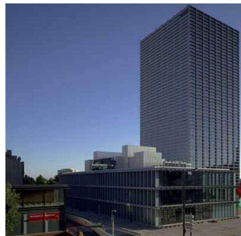
Burgo Building, Oporto (Portugal)
